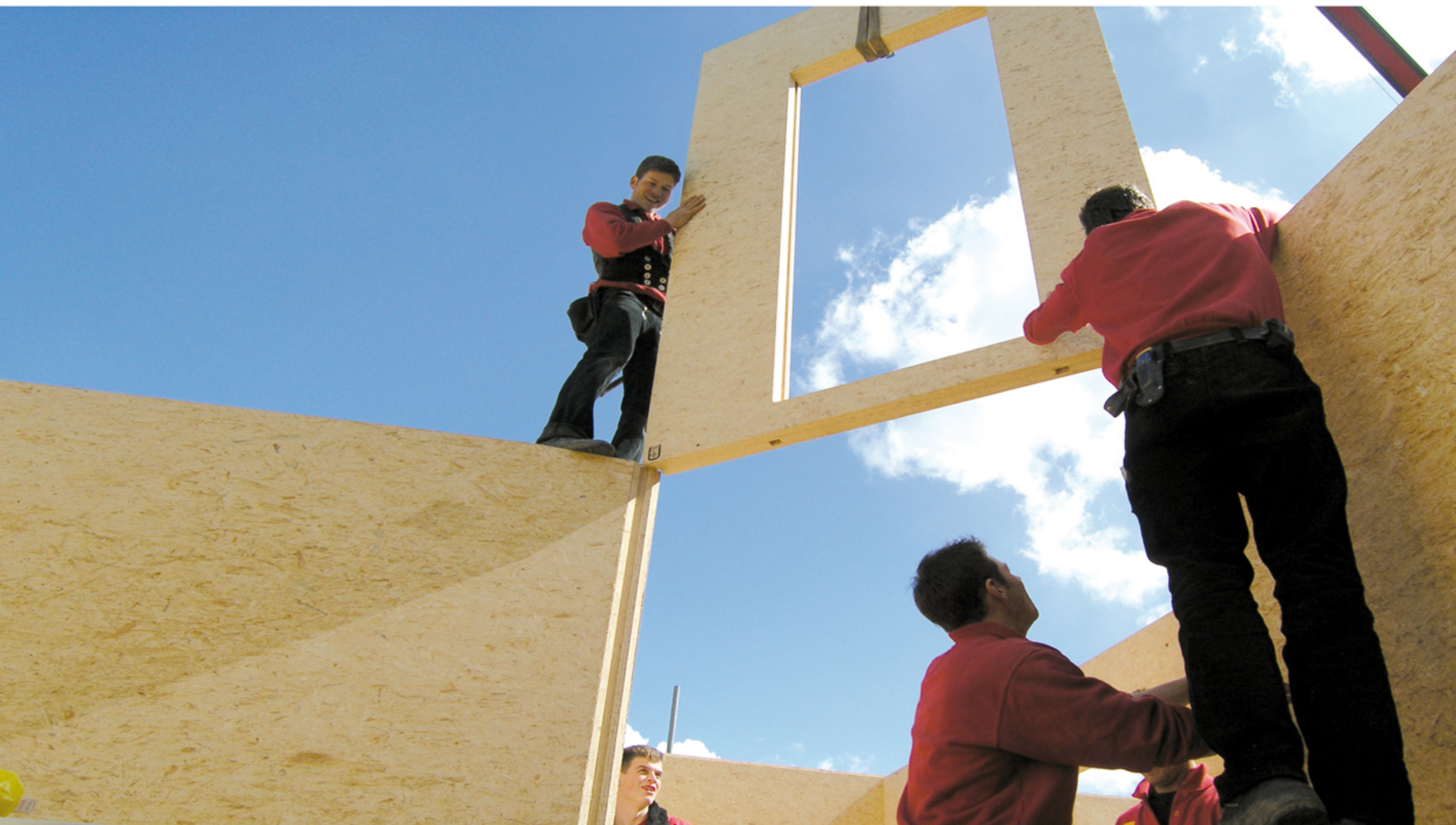
eine durchdachte Stapelreihenfolge ermöglicht die schnelle Montage
